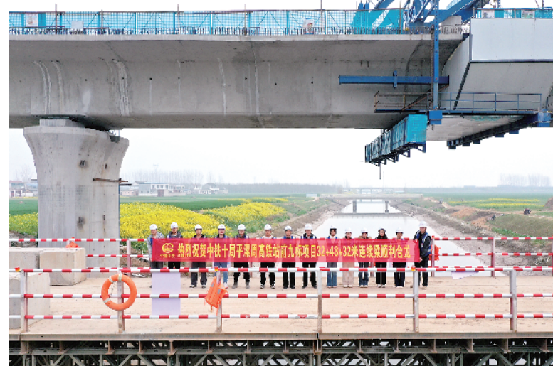
图为商周特大桥跨贾鲁河连续梁合龙现场。
